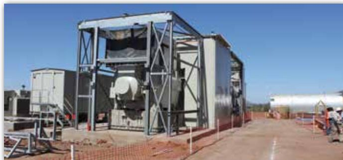
Der Schallschutz für die erste Gasturbine wird gerade aufgebaut.
